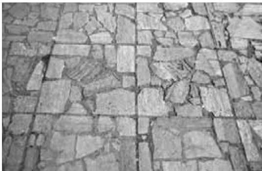
Obr. 87. Novodobá dlažba pochozí terasy z dlaždic, sestavených ze zlomků desek.
