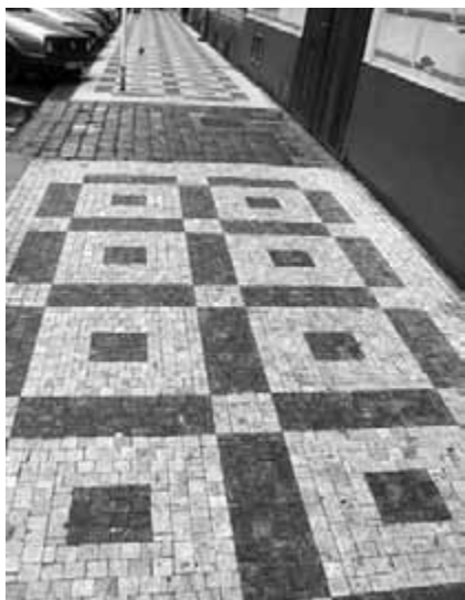
Obr. 3. Nesprávné provedení vzoru šedmdesátka s dámou. Středový čtverec je čtyřřadý jako ostatní části vzoru, ale má být větší.
