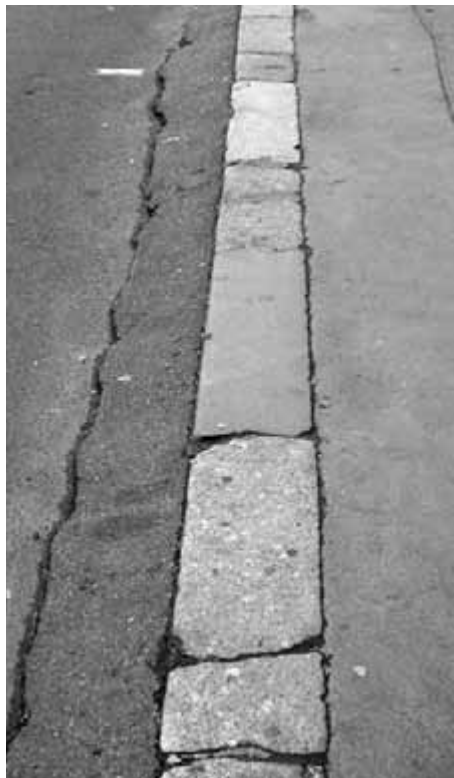
Obr. 33. Nejstarší typ obrubníků. Jsou úzké, mramorové, kladené na výšku. Stejný tvar mají i pozdější subtilní obrubníky žulové.
