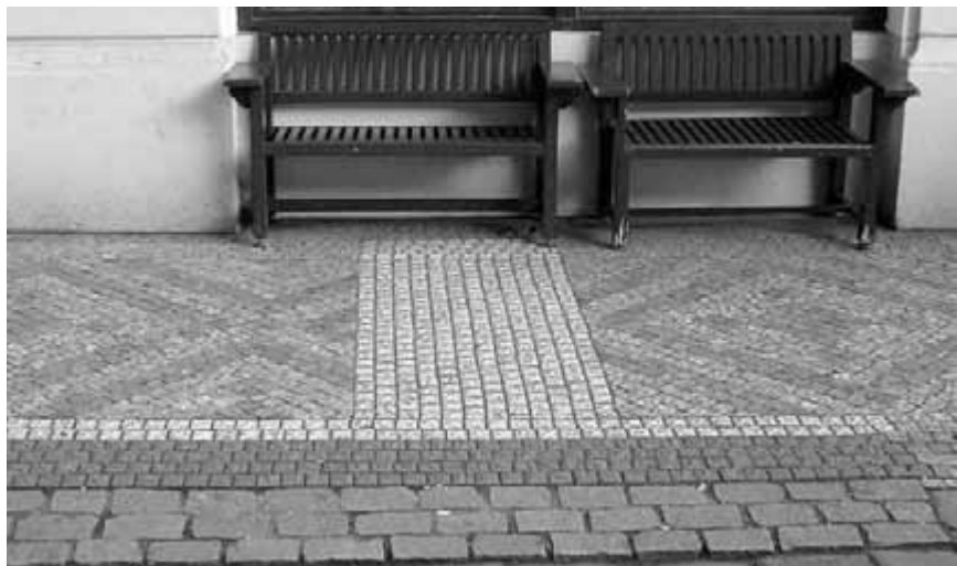
Obr. 21. Nesprávné provedení přechodu pro nevidomé bez respektování vzoru chodníku.
