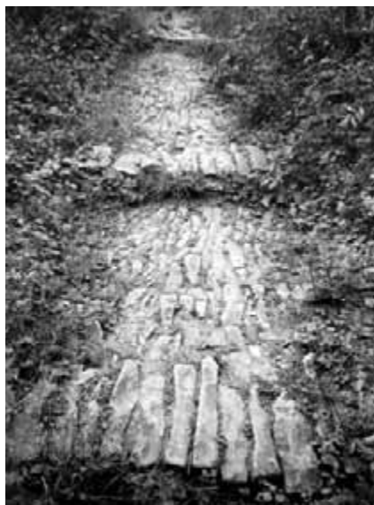
Obr. 23. Vrstevnatý kámen tvaru hranolu, z něhož byly vytvořeny „jezdecké stupně“ ke kostelu (nevhodné z provedeního technického hlediska).
