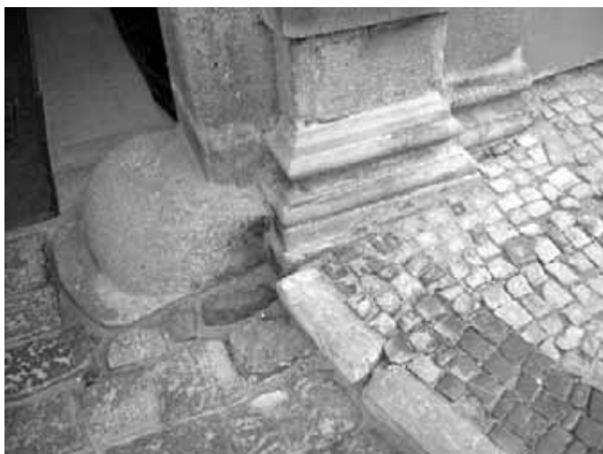
Obr. 73. Důsledkem zvyšování úrovně chodníků a vozovek je nežádoucí překrývání patek portálů (na fotografii), stupňů, spodní hrany sklepních oken a podobných prvků i zvyšování vlhkosti zdiva.
