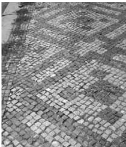
Obr. 5. Rámy s draky na koso, varianta s kříží v křížení, správné provedení. Vzor má dobré proporce i diagonální půlení prvků a vhodnou vícepramenou borduru.
