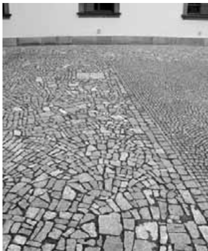
Obr. 16. Nová dlažba nádvoří z lomového kamene a sekané mozaiky.
