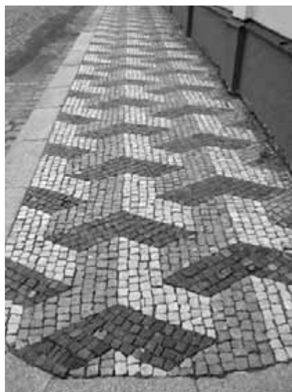
Obr. 63. Původní chodníková mozaika složená do tříbarevného vzoru.
