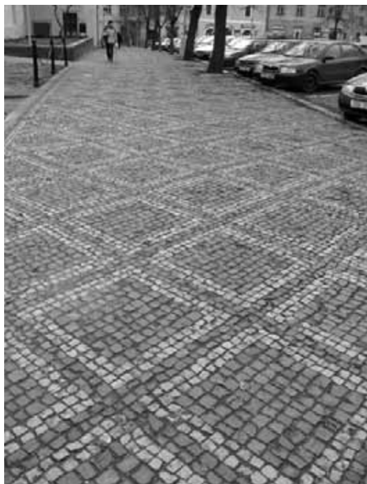
Obr. 79. Původní dvoubarevná chodníková mozaika s pravoúhlým vzorem (rám s výplní).
