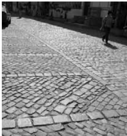
Obr. 26. Řádková dlažba ulice z opracovaných hranolů. Patrný je vydutý příčný profil vozovky a úžlabí, plocha mezi vozovkou a chodníkem je ztuzena příčnými řadami (mezilehlá pole z řádkové dlažby kladené na koso s prostrídanými směry).
