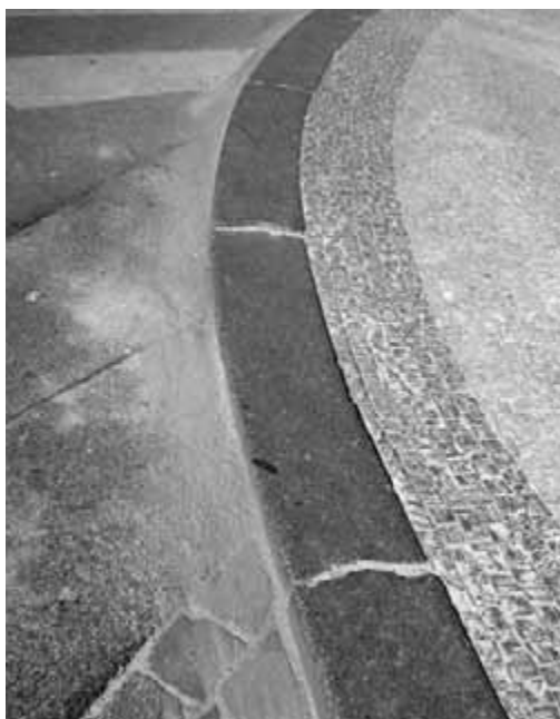
Obr. 30. Běžné masivní žulové obrubníky, kladené na sucho a se zámkem směřujícím doprava.
