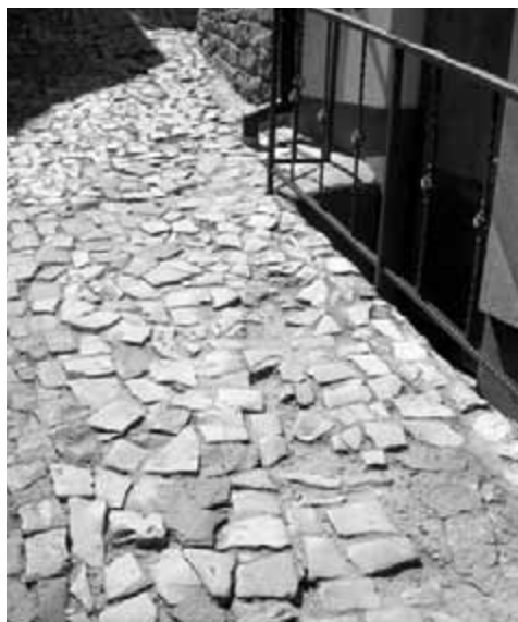
Obr. 11, 12. Dlažby z nepravidelného kamene jsou zpravidla zachovány pouze v málo frekventovaných místech, v odlehlých uličkách, dvorech a podobně. Zaslouží plnou památkovou ochranu.
