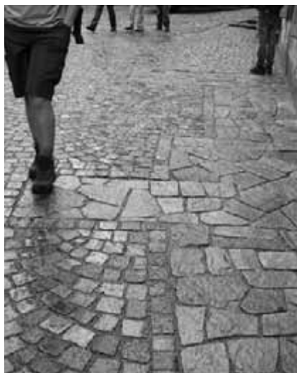
Obr. 105. Novodobá úprava: půdorys nedochované brány vyznačený dlažbou z velkých nepravidelných kamenů.
