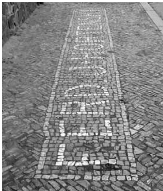
Obr. 32, 33. Nejen vozovky, ale také chodníky mnoha měst byly dříve dlážděny kamenem z nepřiliš vzdálených zdrojů. Před významnými budovami, případně i jinde z něj byly prováděny dosti náročné vzory, výjimečně i nápisy. Těmto originálním dlažbám je nutné věnovat velkou pozornost a dbát o jejich zachování.
