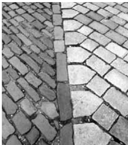
Obr. 39. Dlažba náměstí v úhlopříčné skladbě. Vlevo je patrný vrstevnatý kámen kladený v řádcích podle šířky, vpravo pak velká dlažba, ukončená takzvanými biskupskými čepicemi.
