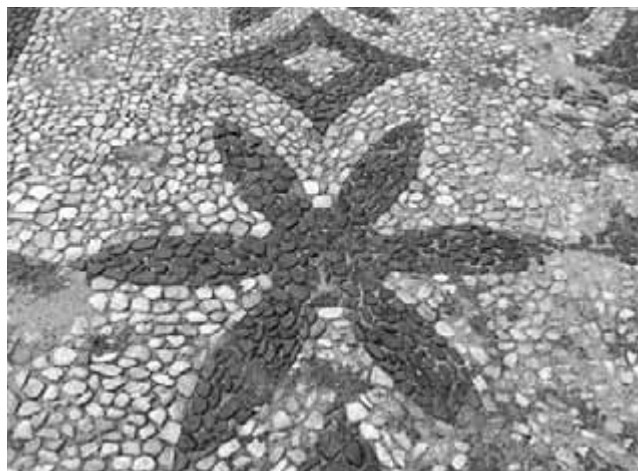
Obr. 32, 33. Nejen vozovky, ale také chodníky mnoha měst byly dříve dlážděny kamenem z nepřiliš vzdálených zdrojů. Před významnými budovami, případně i jinde z něj byly prováděny dosti náročné vzory, výjimečně i nápisy. Těmto originálním dlažbám je nutné věnovat velkou pozornost a dbát o jejich zachování.
