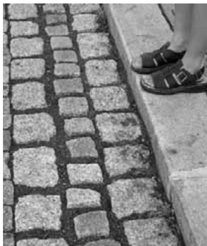
Obr. 113. Široké spáry jsou příčinou uvolňování kostek z podkladu. Kamenná drť umožňuje zatékání dešťové vody do spodní konstrukce.
