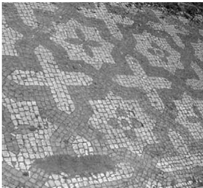
Obr. 7. Hvězdy a kříže, správné provedení s dobrým ukončením vzoru u okraje (propojení pásů) a vhodnou vícepramennou bordurou. Jako středový prvek bývala nejčastěji používána čtyřlístá rozeta nebo čtverec.
