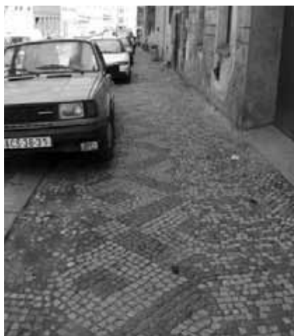
Obr. 78. Původní dvoubarevná chodníková mozaika, poruchy v levé části dlažby jsou způsobeny parkujícími vozidly, poruchy v pravé části jsou zapříčiněny výkopy při ukládání inženýrských sítí.
