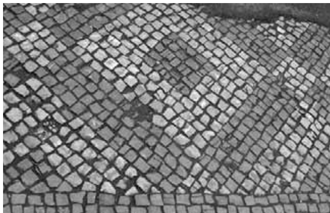
Obr. 1. Sedmdesátka s dámou, správné provedení. Střední čtverec (dáma) je vždy o něco (1–2 řady kostek) větší než ostatní části vzoru, které jsou čtyřřadé.
