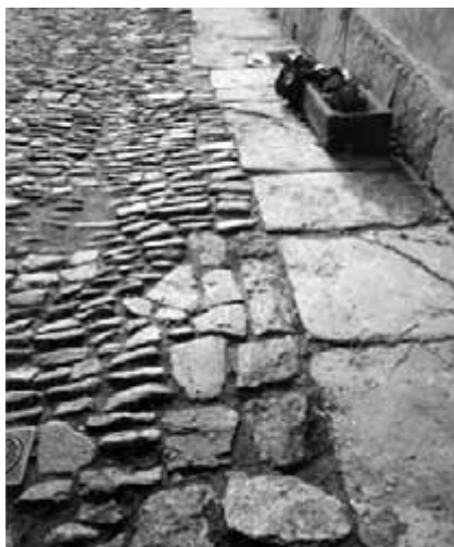
Obr. 14. Dlažby uličky, zleva: dlažba pojížděné plochy z vrstevnatých kamenů kladených do řádků s opravami z větších nepravidelných kamenů, vpravo: podél průčelí kamenné desky.
