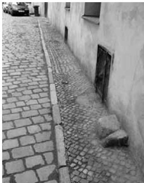
Obr. 92. Řádková dlažba vozovky z opracovaných křemencových krychlí a hranolů s původní vápencovou obrubou, vzniklá v době zavádění zvýšených chodníků. Na fotografii je patrná původní, ručně vyráběná chodníková mozaika a torzo odrazníkového kamene, který byl funkční do doby zavedení zvýšených chodníků.
