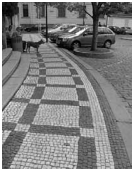
Obr. 73. Původní chodníková mozaika umožnila díky proměnné velikosti koster položení pravoúhlého vzoru, který kopíruje zakřivení chodníku.
