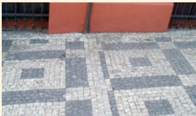
Nesprávné rozvržení vzoru, k němuž došlo při pokládání dlažby. Dláždilo se z protilehlých stran a vzor se uprostřed „nesešel“. Také samotný vzor je proveden nesprávně, středový čtverec má být větší.
