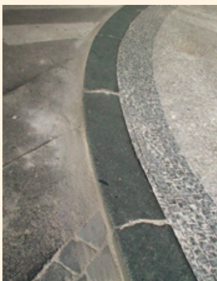
Běžné masivní žulové obrubníky byly na nárožích vždy speciálně tvarovány, aby přesně kopírovaly průběh okraje chodníku.
